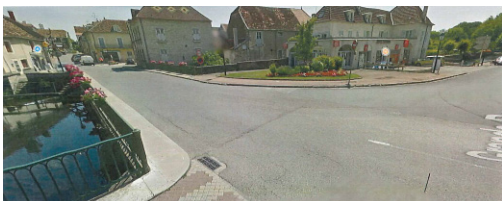
Avant travaux - Ouvrage d'art
