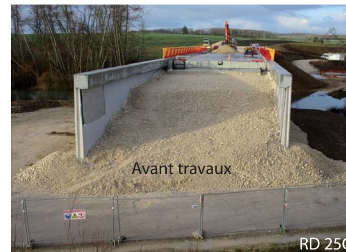
13. Ouvrage d'art sur la RD 25C pour 850 000 €
