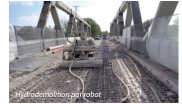
Hydrodémolition par robot
