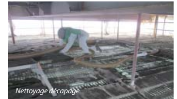
2 e Phase travaux
