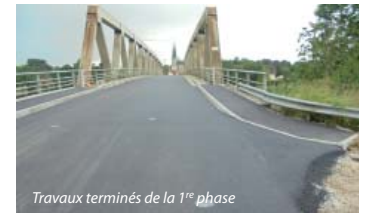
Travaux terminés de la 1 re phase
