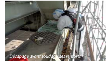
Décapage avant soudage des renforts
