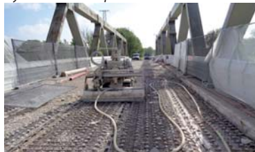
Décapage avant soudage des renforts
