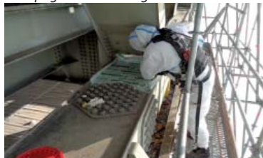
Pose du béton sur la dalle
