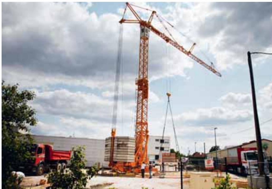
Le collège de Brochon en chantier
