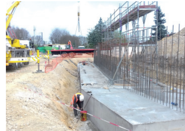
Début 2017 - Construction des fondations du pont
