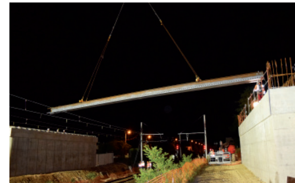
Juin 2017 - Travaux de nuit - Pose des poutres de l'ouvrage
