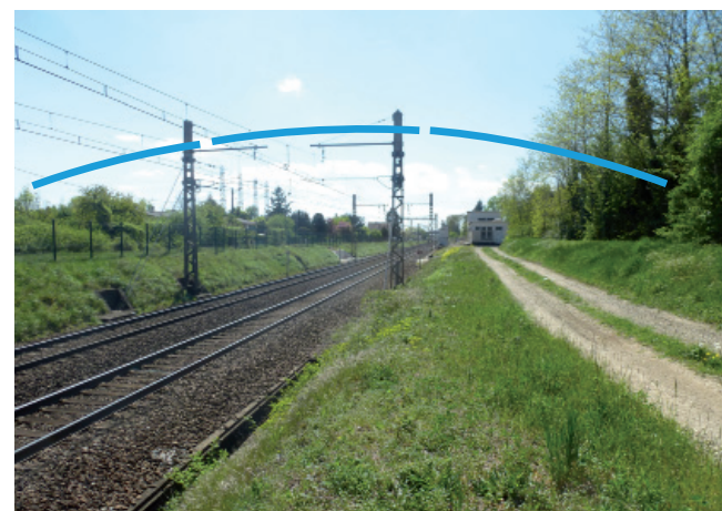
Section de construction du pont sur voies SNCF
