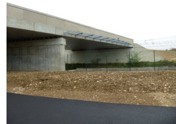
Octobre 2017 - Fin des travaux du pont
