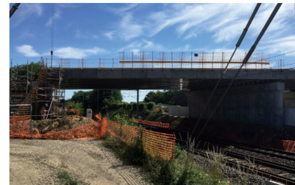
Juillet 2017 - Avancement des travaux du pont (Chape de béton)
