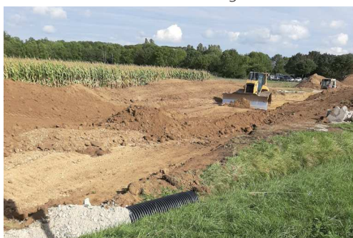
Pendant travaux - Construction giratoire
