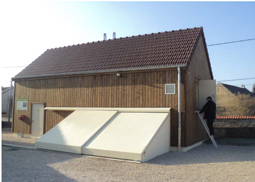
Chaufferie bois collective à Bonnencontre (2015-photo du CD 21)
