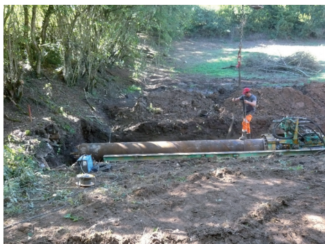
Fonçage pour pose réseaux
