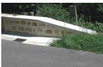
Après travaux - muret
