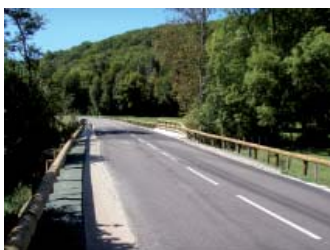
Après travaux - Pont sur le Suzon
