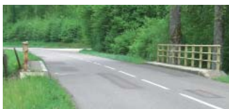
Avant travaux - Pont sur le Suzon
