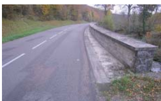
Avant travaux - muret
