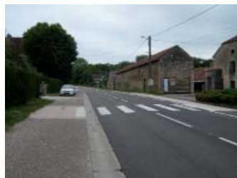
Place après travaux. Arrêt de car
