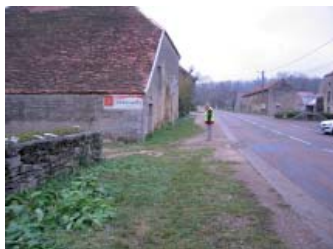
Place avant travaux
