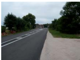
Après travaux - Entrée Ouest
