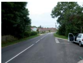
Après travaux - Entrée Est
