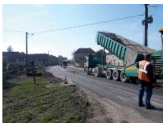
Travaux enrobés entrée Est
