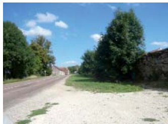
Avant travaux - Entrée Ouest
