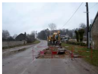
Entrée Est début terrassement
