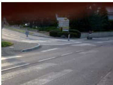
Après travaux - Carrefour RD 970/RD 33
