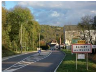
Après travaux - Entrée Ouest
