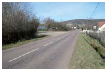
Avant travaux - Entrée Sud RD 33
