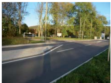
Après travaux - Tourne à gauche - Rue du Châtelet
