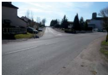
Avant travaux - Carrefour RD 970/RD 33
