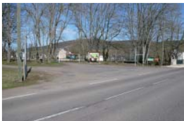
Avant travaux - Tourne à gauche - Rue du Châtelet
