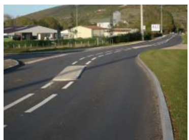
Après travaux - Entrée Sud RD 33
