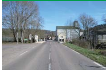
Avant travaux - Entrée Ouest
