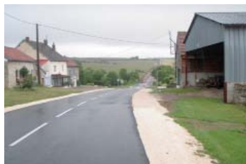
Après travaux - Entrée Est
