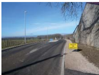
Pendant travaux - Entrée Ouest
