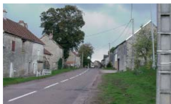
Avant travaux - Agglomération
