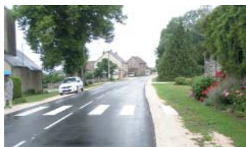
Après travaux - Agglomération
