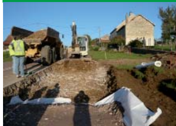
Travaux décaissement entrée Est
