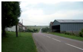
Avant travaux - Entrée Est
