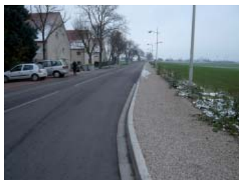
Après travaux - Accès base de LONGVIC
