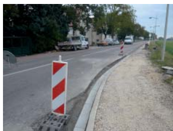
Pendant travaux - Accès base de LONGVIC
