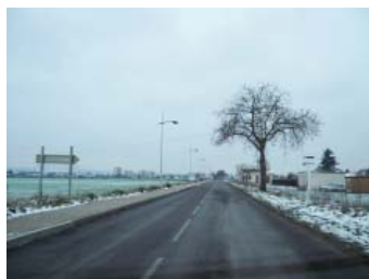
Après travaux - Base de LONGVIC
