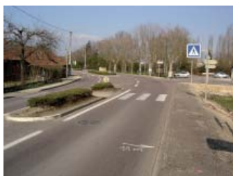
RD 970 - Avant travaux
