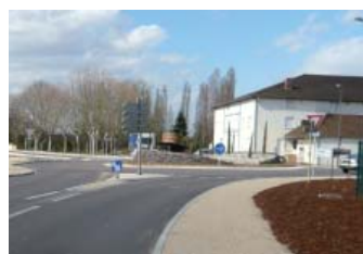
RD970 - Après travaux
