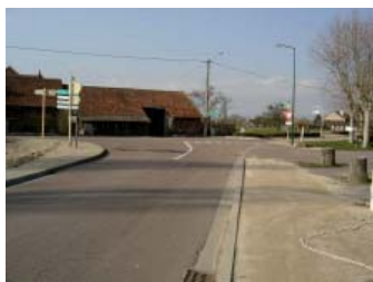
RD 23C - Avant travaux
