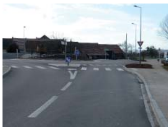
RD 23C - Après travaux
