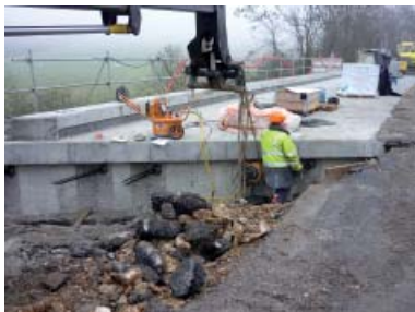
Pendant travaux - réalisation précontrainte
