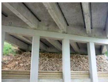
Après travaux - sous l'ouvrage
