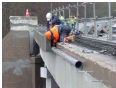
Pendant travaux - Pose des corniches
