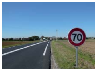
RD 905 Auxonne vers Longeault Après travaux
