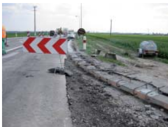
Mise en place vibreurs
