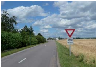
RD 116 Pluvault vers RD905 Avant Travaux
