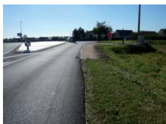
RD116 Collonges vers RD905 Après travaux
