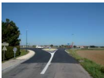
RD 116 Pluvault vers RD905 Après travaux
