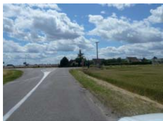
RD116 Collonges vers RD905 Avant travaux
