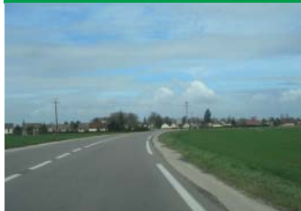
RD 905 Auxonne vers Longeault Avant Travaux
