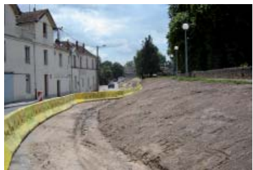
Pendant travaux - Rue du rempart des soupirs
