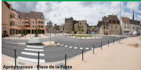
Après travaux - Place de la Poste
