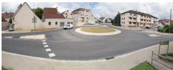
Après travaux - Place de Verdun et RD 24
