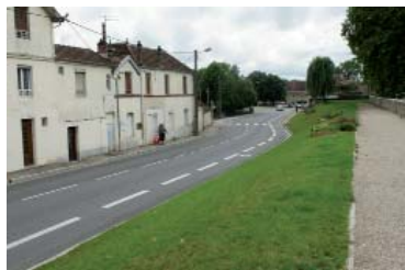
Après travaux - Rue du rempart des soupirs
