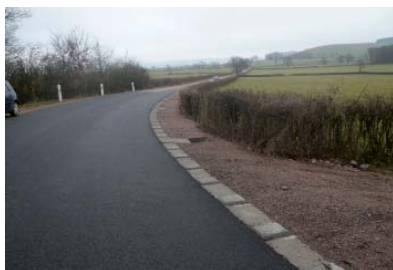
Après travaux RD 26 courbe avec vibreurs
