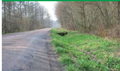
Avant travaux RD 26 en direction de SAINT-THIBAULT
