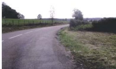
Avant travaux - Carrefour RD 70 - RD 26 en direction de SAINT-THIBAULT
