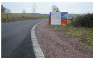
Après travaux - Carrefour RD 70 - RD 26 en direction de SAINT-THIBAULT - courbe avec vibreurs
