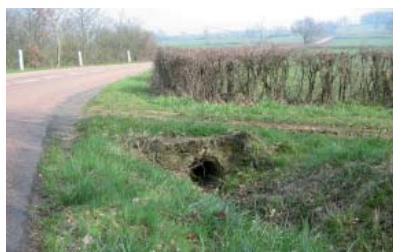
Avant travaux RD 26 en direction de VITTEAUX
