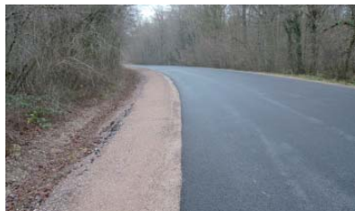
Après travaux RD 70 en direction de VITTEAUX renforcement de l'accotement
