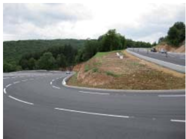
Après travaux - Vue lacet vers bas
