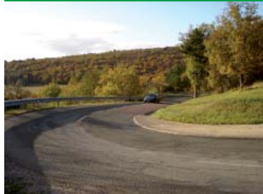
Avant travaux - Vue lacet vers bas
