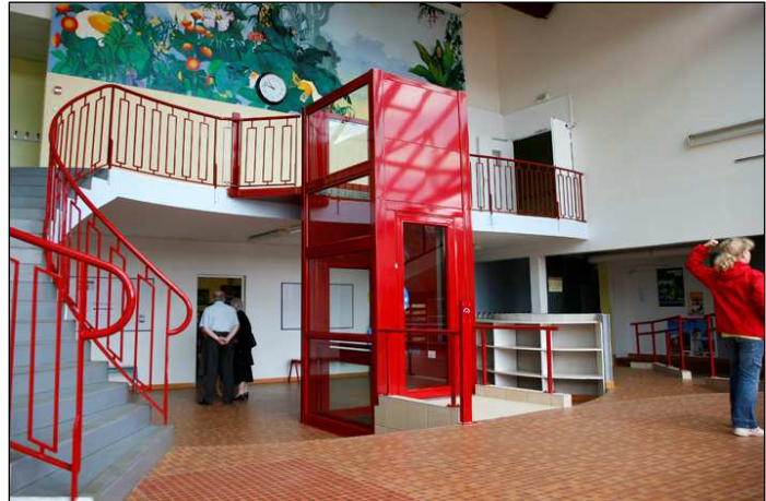
Installation d'un ascenseur, collège de Vitteaux
